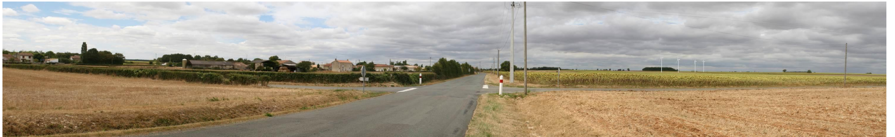
Illustration 3 : Les éoliennes du projet vues depuis les abords de la forêt domaniale de Chizé
